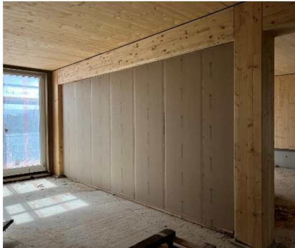
Innenwände aus Strohbauplatten
