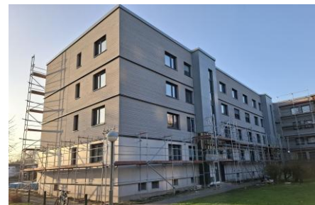
Foto: dena / Rheinwohnungsbau
